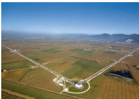
VIRGO à Cascina, près de Pise. Ce gigantesque interféromètre, dont les bras font plusieurs kilomètres, est un détecteur d'ondes gravitationnelles. Crédit CNRS
